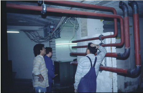
Abb.: Umbaumaßnahmen für den neuen SUN Cluster
