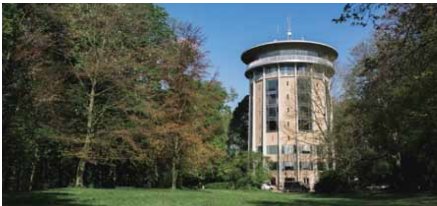
Arbeiten im Belvedere-Drehturm in Aachen
