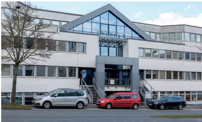
Abb. 1.16: Außensicht des Dienstgebäudes Kackertstraße 10.
