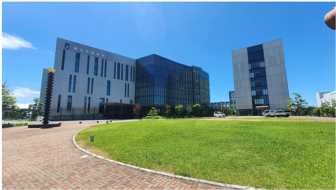
Abb. 6.7: Hauptgebäude von RIKEN in Kobe.
